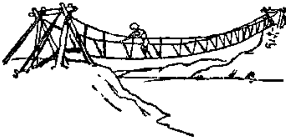
En los montes Himalaya, los nativos construyen puentes con tres cuerdas
